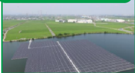
細池水上太陽光発電所(岐阜)
