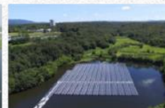
林池水上太陽光発電所(愛知)
