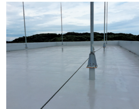
工場棟の遮熱防水処理した屋上
