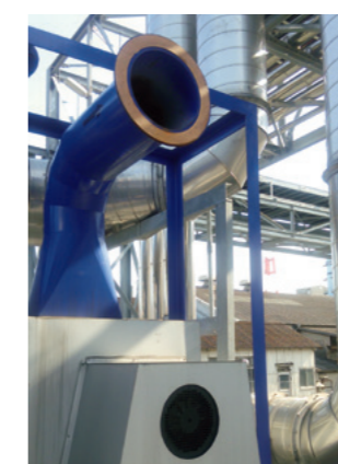
工場棟排気口 南側
