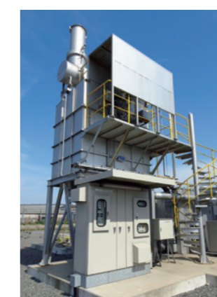
溶剤燃焼装置(RTO)
