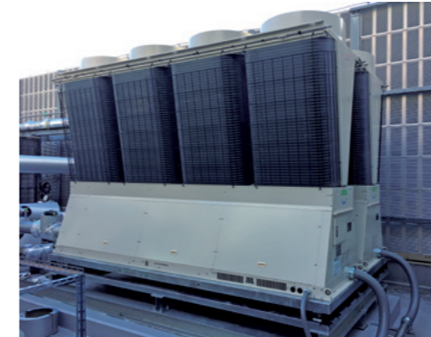
工場棟屋上に設備した生産チラー
