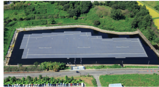
嵐山水上太陽光発電所
