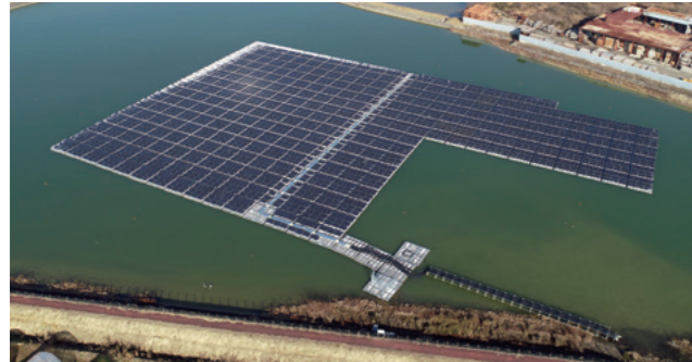
穴沢池水上太陽光発電所
