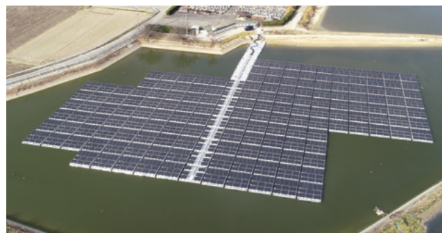
小林池水上太陽光発電所
