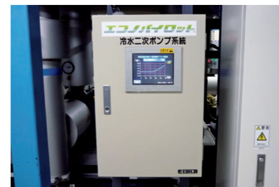
冷温水ポンプ制御盤
