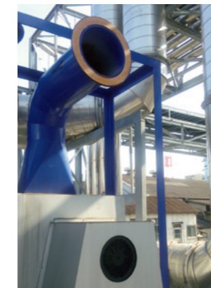
工場棟排気口 南側
