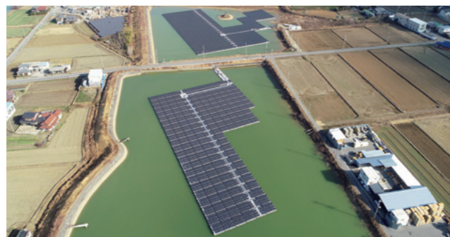
魚住池草谷池水上太陽光発電所
