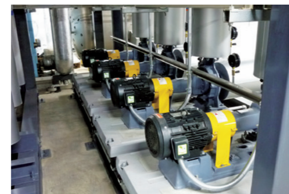
冷温水ポンプ
