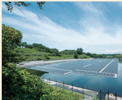
嵐山水上太陽光発電所
