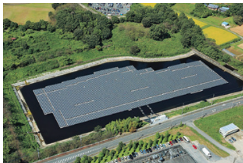
嵐山水上太陽光発電所
