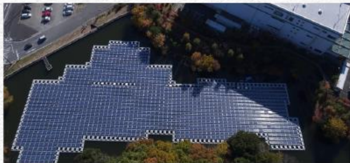
嵐山大沼水上太陽光発電所 開所(2017年12月～)
