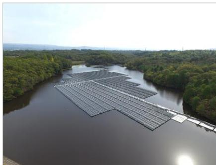
一般に太陽光パネルは温度が上昇すると発電量が減少する性質がありますが、水上設置型は水面の冷却効果により太陽光パネルの温度上昇を抑えることができるため、陸上設置型に比べて発電効率の点で有利といえます。また、水面への日射をさえぎることによるアオコ発生の抑制も期待できます。
