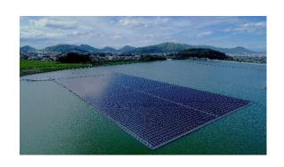
一般に太陽光パネルは温度が上昇すると発電量が減少する性質がありますが、水上設置型は水面の冷却効果により太陽光パネルの温度上昇を抑えることができるため、陸上設置型に比べて発電効率の点で有利といえます。また、水面への日射をさえぎることによるアオコ発生の抑制も期待できます。
