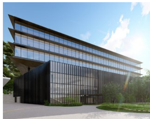
新開発棟(埼玉県・嵐山町)
