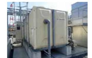
高効率モジュールチラーでつくられた生産用の冷却水を貯めるタンク
